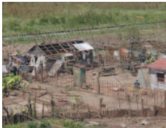
Zerstörte Häuser auf dem Land.
